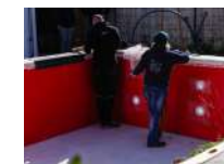
Pose du troisième panneau
