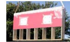
Pose du second panneau
