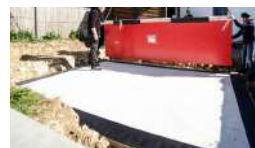
Pose du premier panneau
