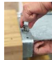
Pose des platines d'angles Répéter l'opération à chaque pose de panneau
