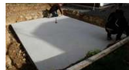
Vous préparez la dalle béton
